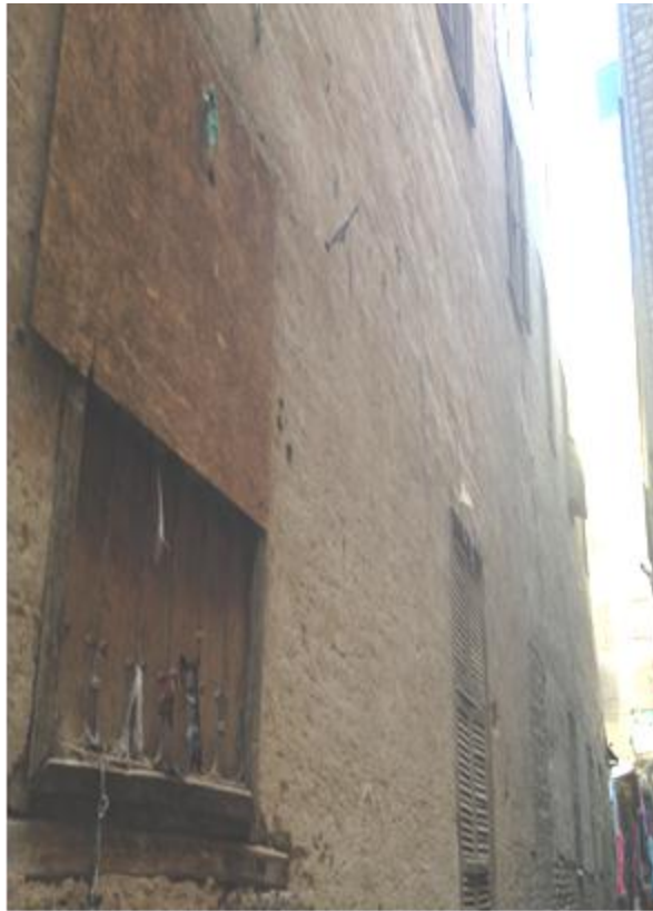
(لوحة ٤) توضح الميدات الخشبيه المستخدمه لتقوية الجدران
